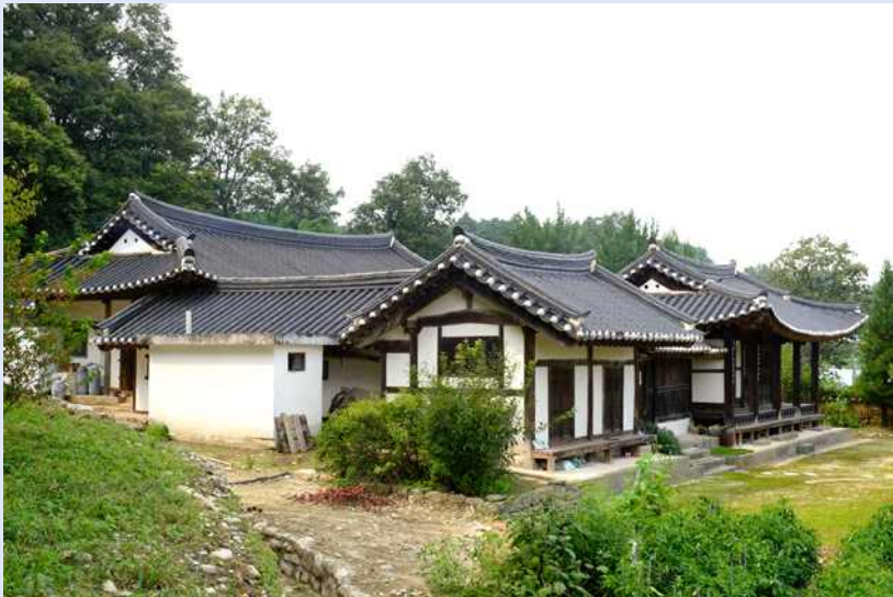
강릉 만성 고택 내부 전경
